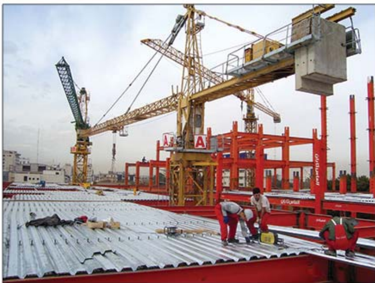
کیفیت و دقت بالا در ساخت و اجرا
