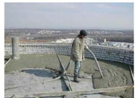
تصویر ۴: ریختن فوم بتن به صورت یک جا، جهت شیب بندی و ایزولاسیون
