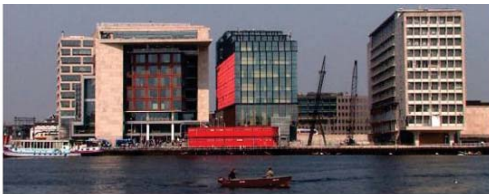
عکس شماره ۷: استرداک آمستردام، این تصویر کتاب‌خانه عمومی را نشان می‌دهد (چپ). که در آن سیستم‌های تقسیم انرژی و در پشت بام‌های آن از سیستم فتوولتایی استفاده شده است.
