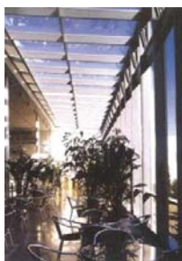
تصویر ۱۸: نورگیری طبیعی از سقف
