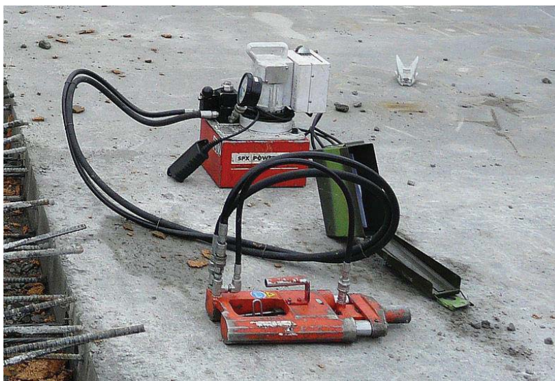
شکل ۳: جک (برای اعمال نیروی پیش تنیدگی)
