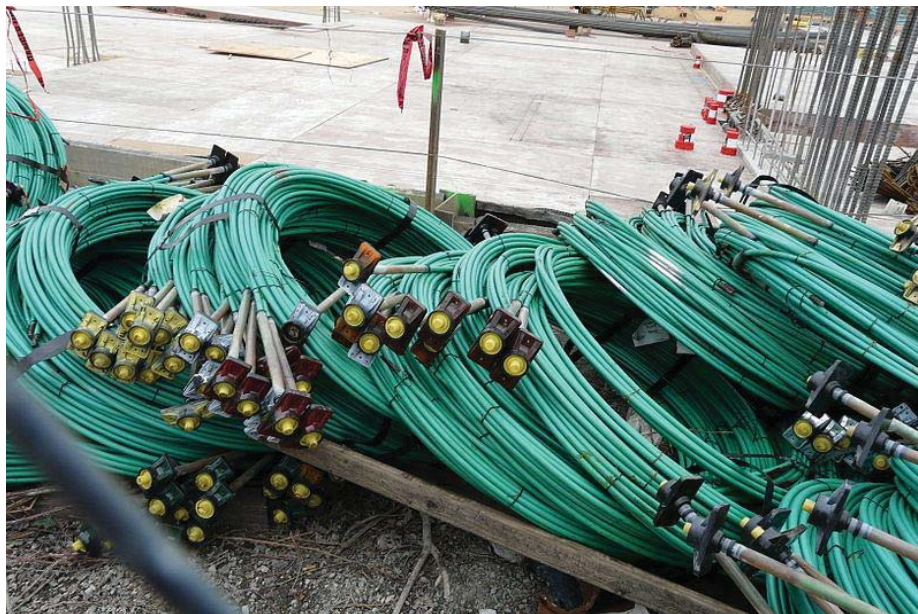
شکل ۱: نمایی از کابل‌های پیش‌تنیدگی
