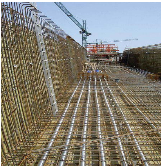
شکل ۵: کابل‌های پیش‌تنیدگی در عرشه پل
