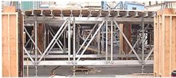
شکل ۱-۵۵ قالب های میز پرنده خریایی
