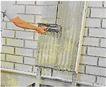
شکل ۹-۵ نصب عایق فوم پلی استایرن از پایین به بالا
