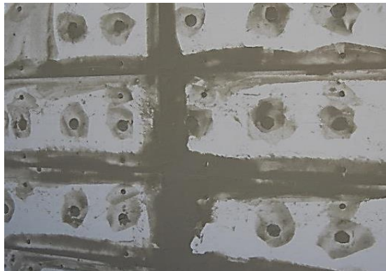
شکل ۵-۱۲ پوشاندن گل‌میخ‌ها با اندود زیرین
