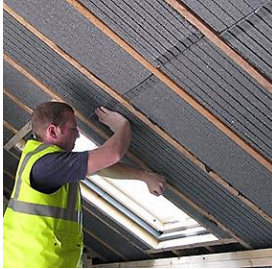
شکل ۶-۱۸ عایق‌کاری بام شیب‌دار با پنل شیشه سلولی
