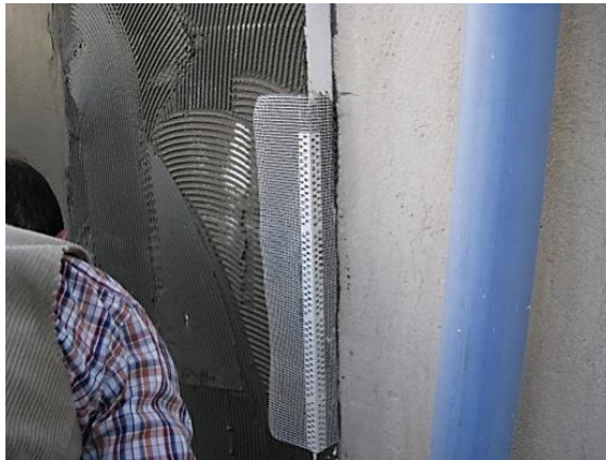
شکل ۵-۱۴ نصب پروفیل کنج
