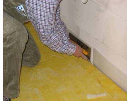
شکل ۳۵-۶ جداسازی کف شناور از دیوار به وسیله ماده الاستیک
