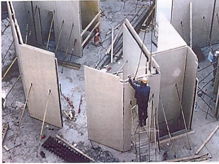
شکل ۱-۶ نصب پانل‌های دیوار در سیستم دیوار دولایه بتنی
