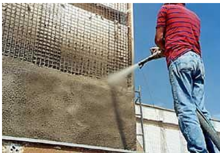
شکل ۱-۱۰ بتن پاشی بر روی پانل‌ها
