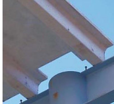
شکل ۲-۲۰ جزئیاتی از قطعات سقفی دابل تی
