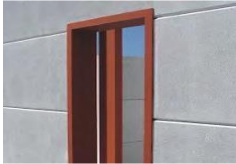
شکل ۱-۳۵ نصب نعل درگاه و بازشوها
