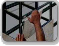
۲. نحوه نصب سنگ بر روی فرم فلزی
