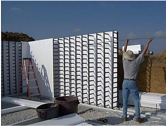
شکل ۱-۱۷۲ نمونه قالب ماندگار نواری قائم
