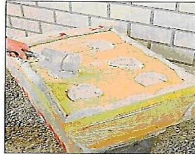
شکل ۸-۵ قرار دادن چسب در تمامی پیرامون و چند کپه در قسمت مرکزی تخته
