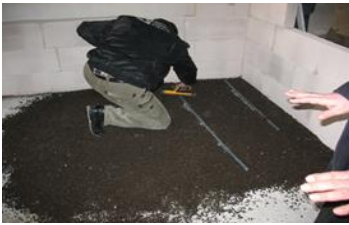
شکل ۶-۳۳ آماده‌سازی سطح کف برای اجرای کف شناور
