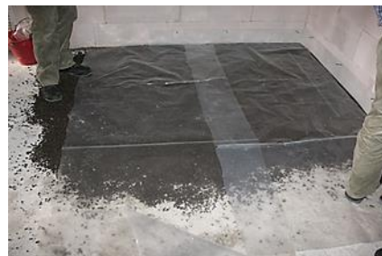
شکل ۶-۳۴ اجرای ماده الاستیک بر روی کف
