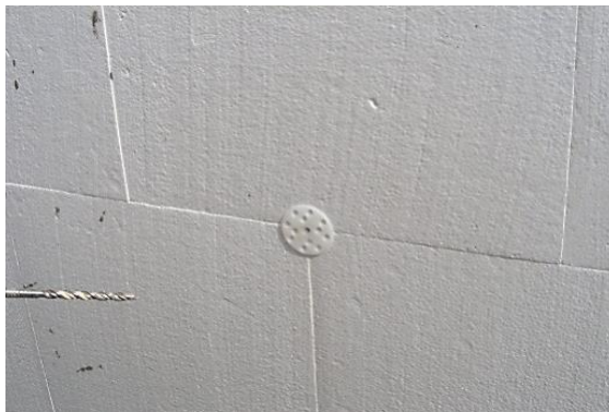
شکل ۱۰-۵ قرار گرفتن تخته‌ها به صورت یکی در میان (آجرچین)
