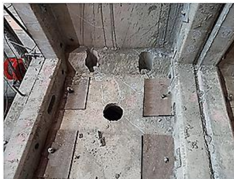
شکل ۴۴-۱ نحوه اتصال بلوک به فونداسیون
