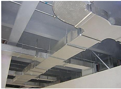
شکل ۶-۲۲ عایق کاری کانال‌های تهویه هوا
