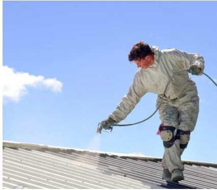
شکل ۶-۲۴ اجراء پوشش بازتابنده حرارتی
