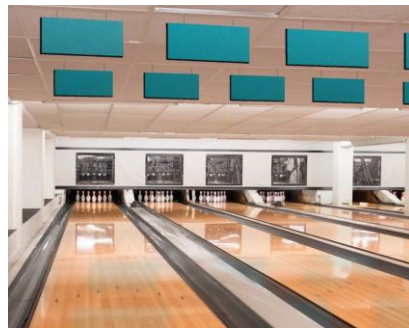
شکل ۶-۳۰ استفاده از بافل‌ها در سقف
