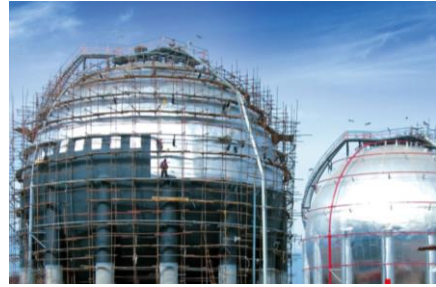
شکل ۳-۶ عایق کاری مخازن با FEF
