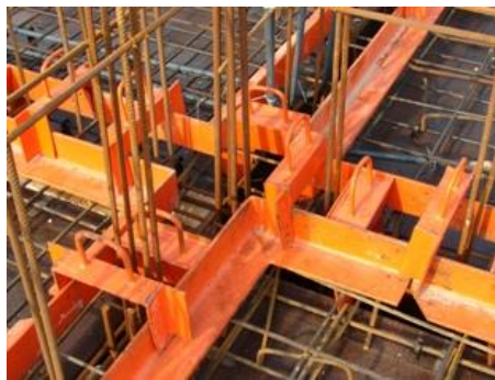
شکل ۵۳-۱ نمونه ای از قالب رامکا که قبل از بتن ریزی سقف
