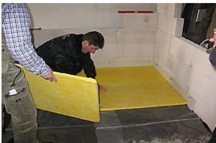
شکل ۶-۳۴ اجرای ماده الاستیک بر روی کف
