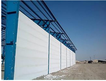
شکل ۳-۷ اجرای پانل AAC
