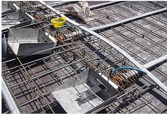
شکل ۲-۲۸ محل مهار انتهایی کابلها قبل از کشش
