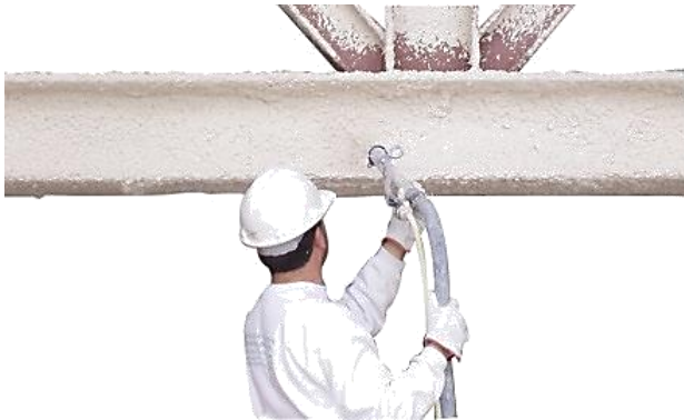
شکل ۷-۱ نمونه‌ای از نحوه اجرای پوشش‌های محافظ حریق پایه معدنی پاششی
