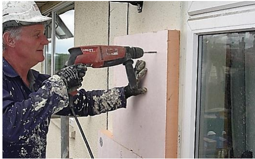
شکل ۶-۲۰ عایق کاری دیوار خارجی با عایق فوم فنولیک
