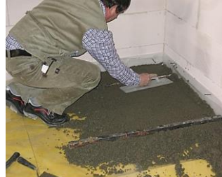
شکل ۳۷-۶ بتن ریزی کف شناور با استفاده از ملات مخصوص
