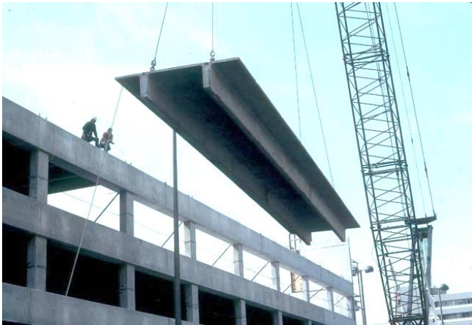
شکل ۱۹-۲ نمایی از یک قطعه در سقف دابل تی
