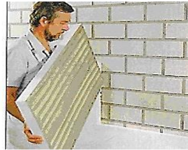
شکل ۹-۵ نصب عایق فوم پلی استایرن از پایین به بالا
