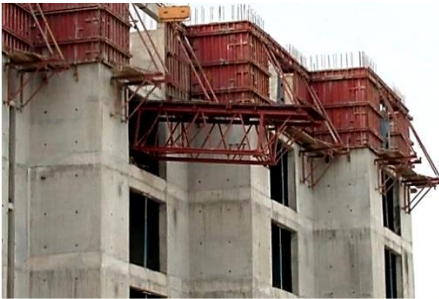
شکل ۱-۵۴ نمونه‌هایی از قالب میزپرنده در حال انتقال
