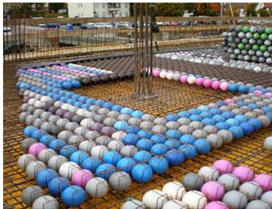
شکل ۲-۲۴ اجرای سقف توپر در اطراف ستون برای جلوگیری از برش پانچ
