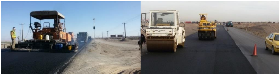
شکل ۴-۲۰ اجرای آسفالت پودرلاستیکی
