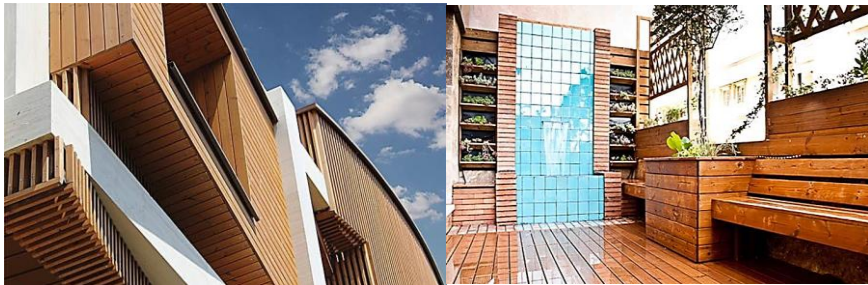
شکل ۵-۱۷ کاربرد ترموود در خارج از ساختمان
