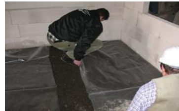
شکل ۶-۳۳ آماده‌سازی سطح کف برای اجرای کف شناور
