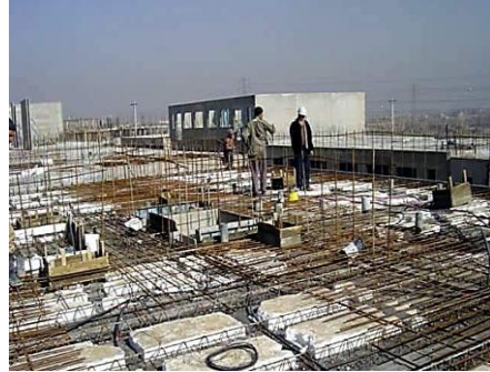
شکل ۱-۵ سقف پیش ساخته قبل از بتن‌ریزی
