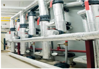
شکل ۴-۶ عایق کاری لوله با FEF
