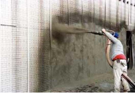
شکل ۱-۳ تصاویر مربوط به بتن پاشی پانل‌ها
