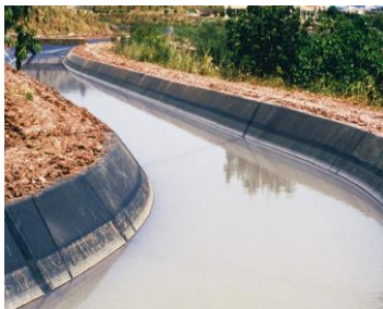
شکل ۴-۱۶ نمونه استفاده از ژئوممبرین‌ها در آب‌بندی کانال‌ها و حوضچه‌های مصنوعی
