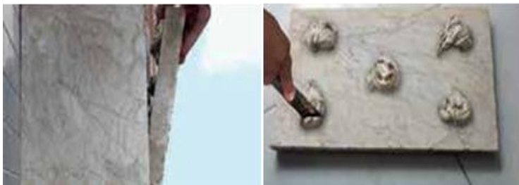
شکل ۴-۷ کندن قسمت‌های سست و لقمه گذاری
