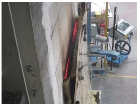
شکل ۸-۷ عملکرد ناصحیح در آتش در نتیجه طراحی غیراصولی
