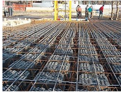
الف- دال مجوف قبل از بتن‌ریزی
