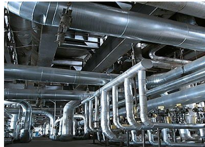
شکل ۶-۲۱ عایق کاری لوله‌های تاسیساتی
