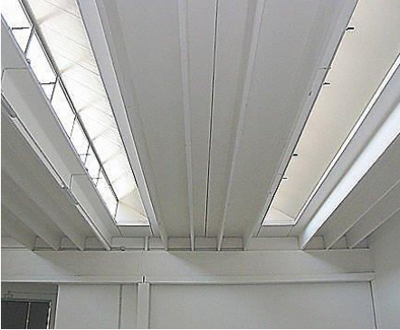
شکل ۲-۲۰ جزئیاتی از قطعات سقفی دابل تی
