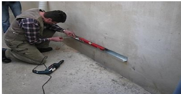
شکل ۵-۷ تراز کردن پروفیل U
