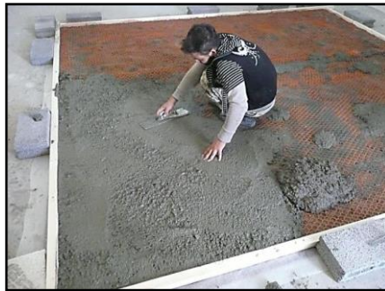
شکل ۳۸-۶ بتن ریزی معمولی با استفاده از شبکه مش
