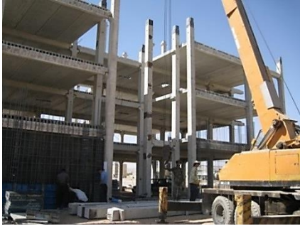
شکل ۲-۲۱ نمایی از قطعات هالوکور
