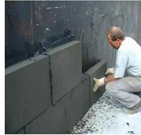
شکل ۶-۱۷ ساخت دیوار با پنل‌های شیشه سلولی
