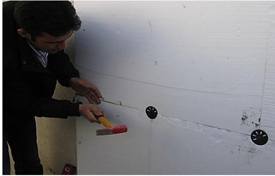
شکل ۵-۱۱ کوبیدن میخ پلاستیکی اتصال با چکش
