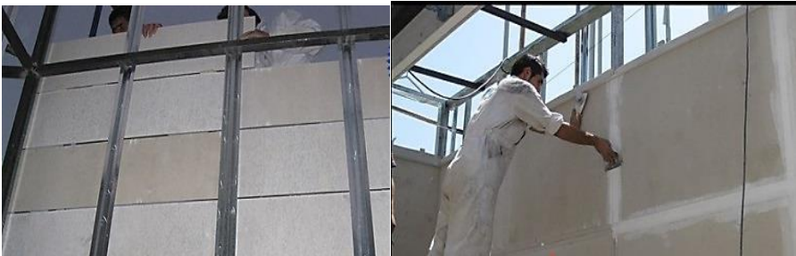
شکل ۳-۵ سیستم دیوارهای خشک با استفاده از صفحات سیمانی مسلح شده با الیاف
