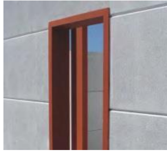
شکل ۳-۸ نصب نعل درگاه و بازشوها
