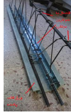
شکل ۲-۲ اتصالات تیرچه بدون جوش
