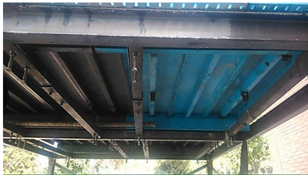
شکل ۲-۹ نمای زیرین قالب بندی سقف
