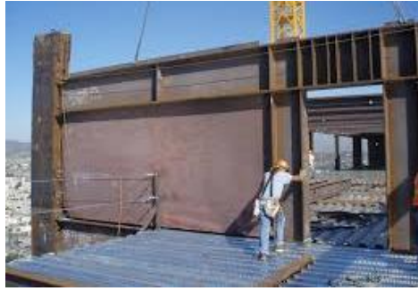
شکل ۱-۴۷ دیوار برشی فولادی
