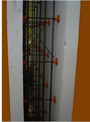
شکل ۱-۱۶ یک نمونه قالب ماندگار پانلی دارای میلگردگذاری کارخان‌های
