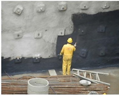
شکل ۶-۱۰ پاشش دو جز مخلوط شده به سطح دیوار
