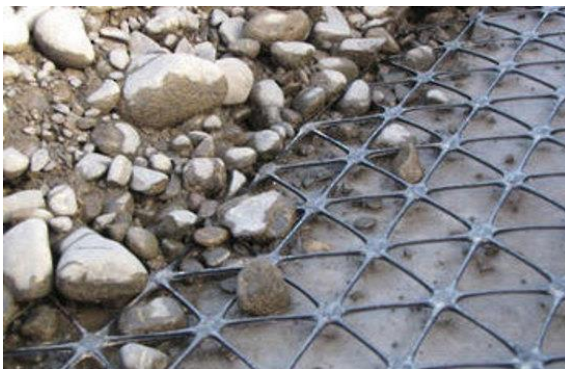
شکل ۴-۱۵ نمونه استفاده از ژئوگرید به عنوان مسلح کننده خاک
