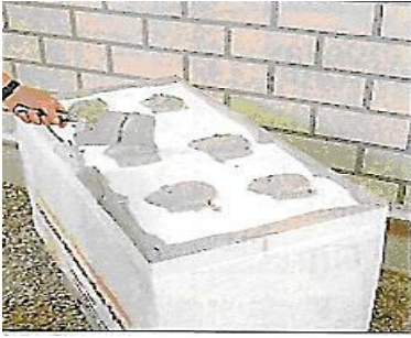
شکل ۸-۵ قرار دادن چسب در تمامی پیرامون و چند کپه در قسمت مرکزی تخته
